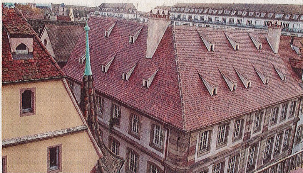
Le bâtiment de la Société des Amis des Arts et des Musées de Strasbourg, situé à l'angle des rues de l'Épine et des Serruriers, est débarrassé de ses échafaudages. DOCUMENT REMIS
